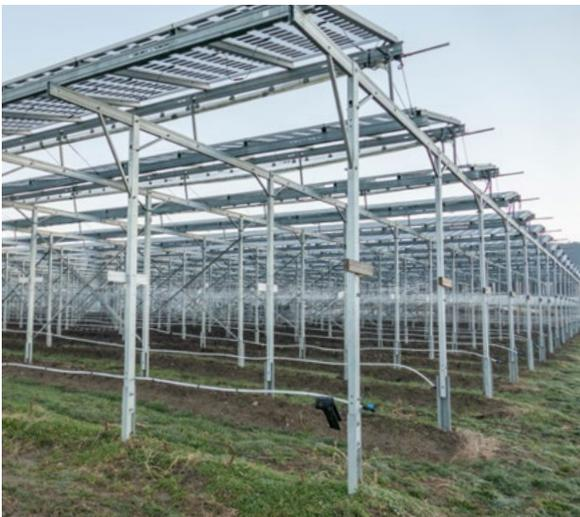
Système d'Insolight: modules mobiles à 3,5 mètres de hauteur.
